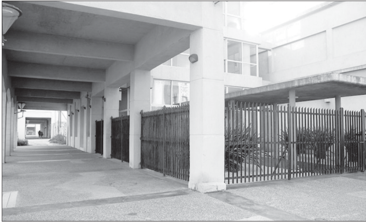
Escenario. El edificio de avenidas 2 y 75, donde se perpetró el novedoso episodio delictivo a comienzos de octubre del 2022
