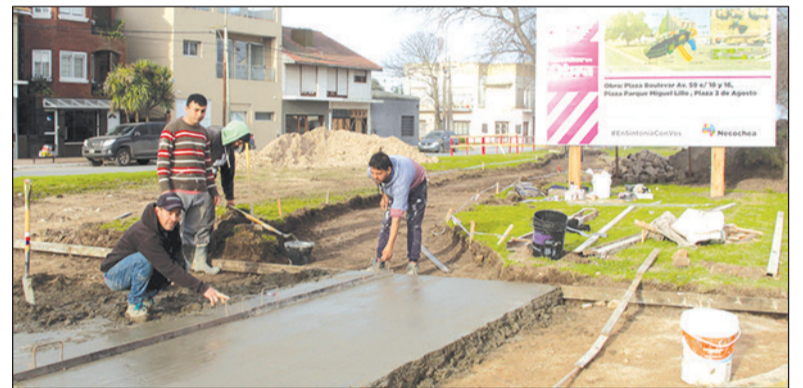
Avanzada. Luce la reforma en la plazoleta de 59 y 18
