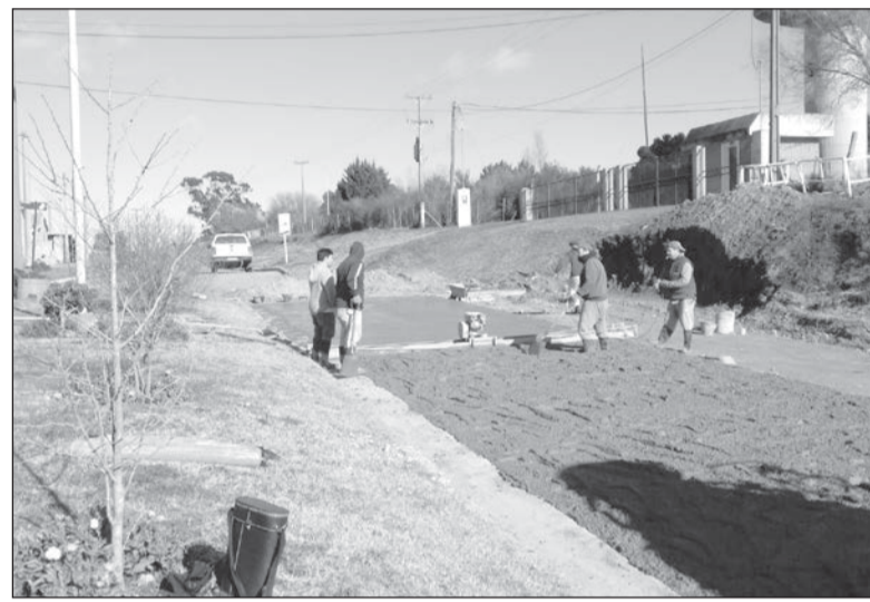
Pavimento. Comenzó la obra en la calle Alem, de San Manuel
