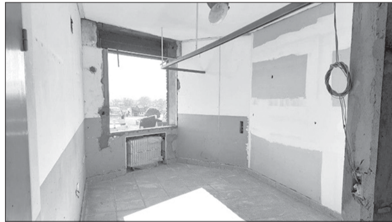
En construcción. Los trabajos se concentran en el área de pediatría
