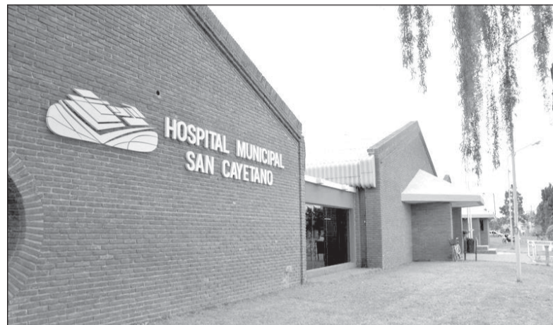
Ampliación. Proyectan una extensión del edificio del quirófano del hospital municipal de San Cayetano
